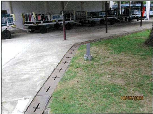
ภาพถ่ายที่ 2.2-10 รางระบายน้ำและฝาปิดด้านบนรางระบายน้ำ
